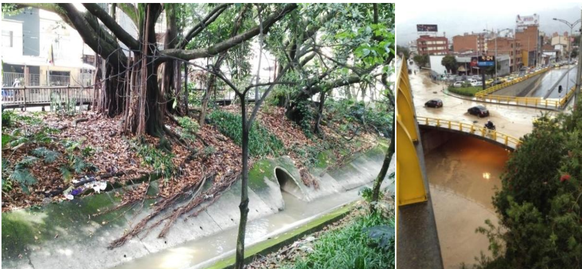
Figura 5. Cauce Quebrada La Picacha en estado normal (izquierda). Fuente: V. Fajardo Castaño y J. Flórez Rendón. Cauce Quebrada La Picacha en evento pluvial (derecha). Fuente: https://twitter.com/anfejara/status/148513590750621696/photo/1 .
